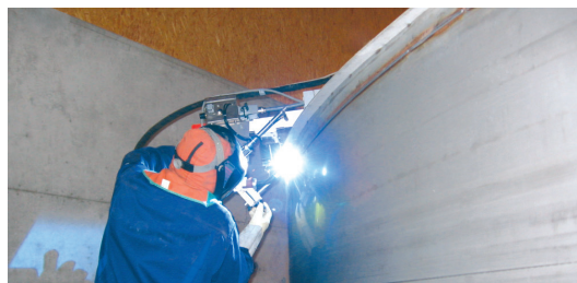
Kegeldach wird mit Behältermantel verschweißt.
