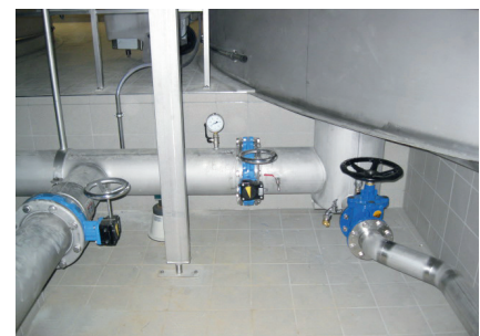
Grundablass mit Entnahmetopf
