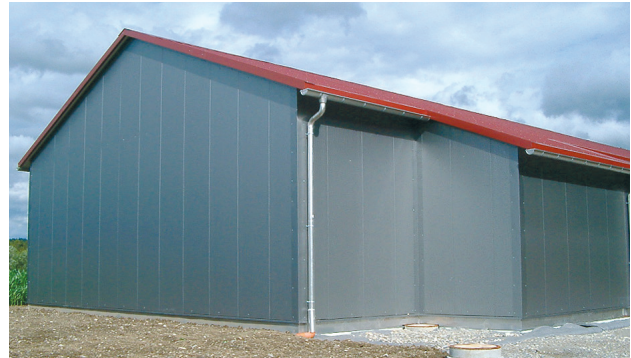
Anlage 2 x 500 m 3 in Industriehallenkonstruktion
