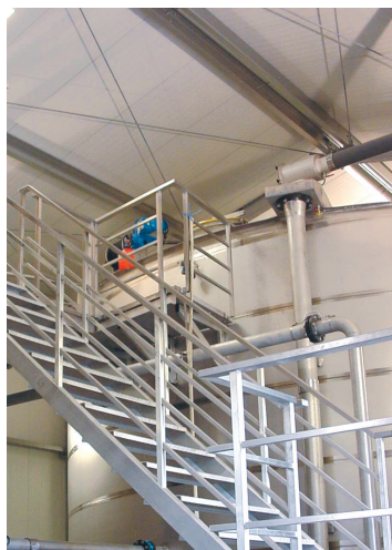
Podest- und Treppenkonstruktionen
