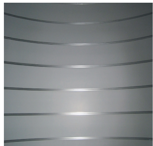
Innenansicht eine gebeizten Behälters
