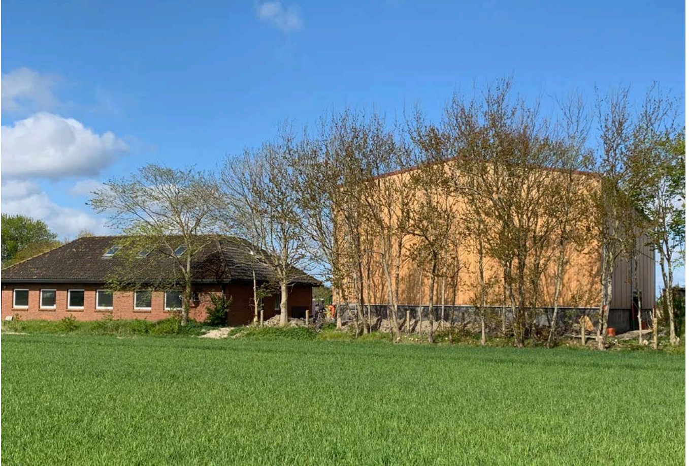
Bild 1: Druckerhöhungsstation mit neuer Speicheranlage
