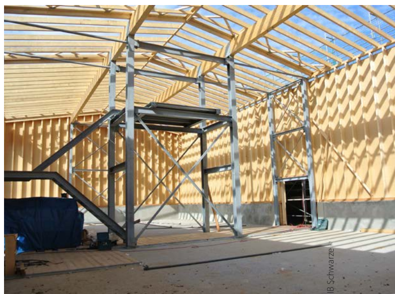
Bild 5: Holzbau und Stahlbau
