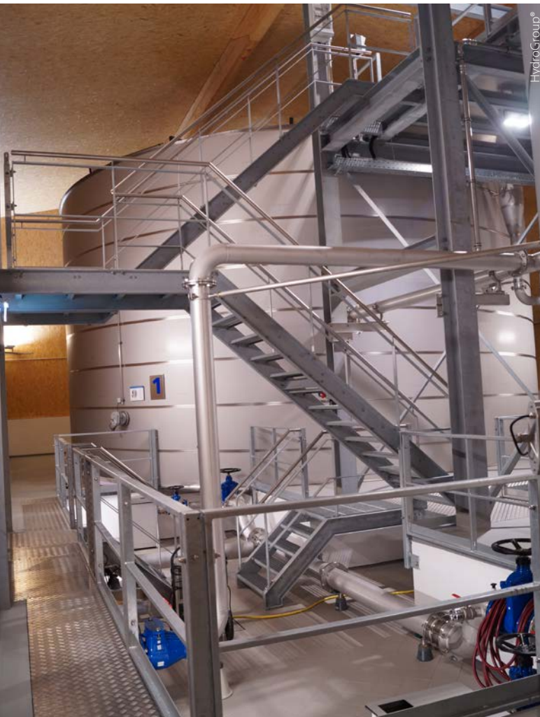
Bild 7: Treppenhhaus und Behälteranlage
