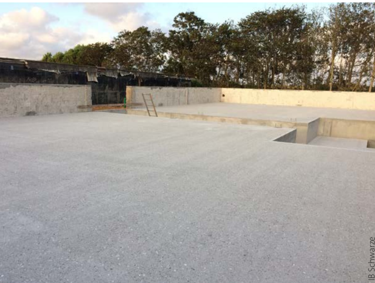
Bild 3: Neue Behältersohle mit Rohrkeller
