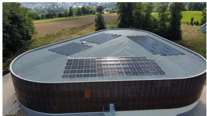
Bild 2: Luftaufnahme der neuen Behälteranlage in Bauphase
