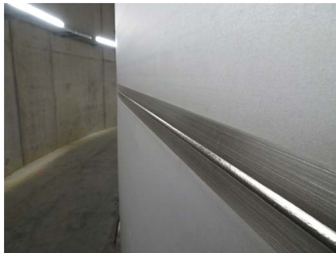
Bild 4: Schweißnaht im Behältermantel
