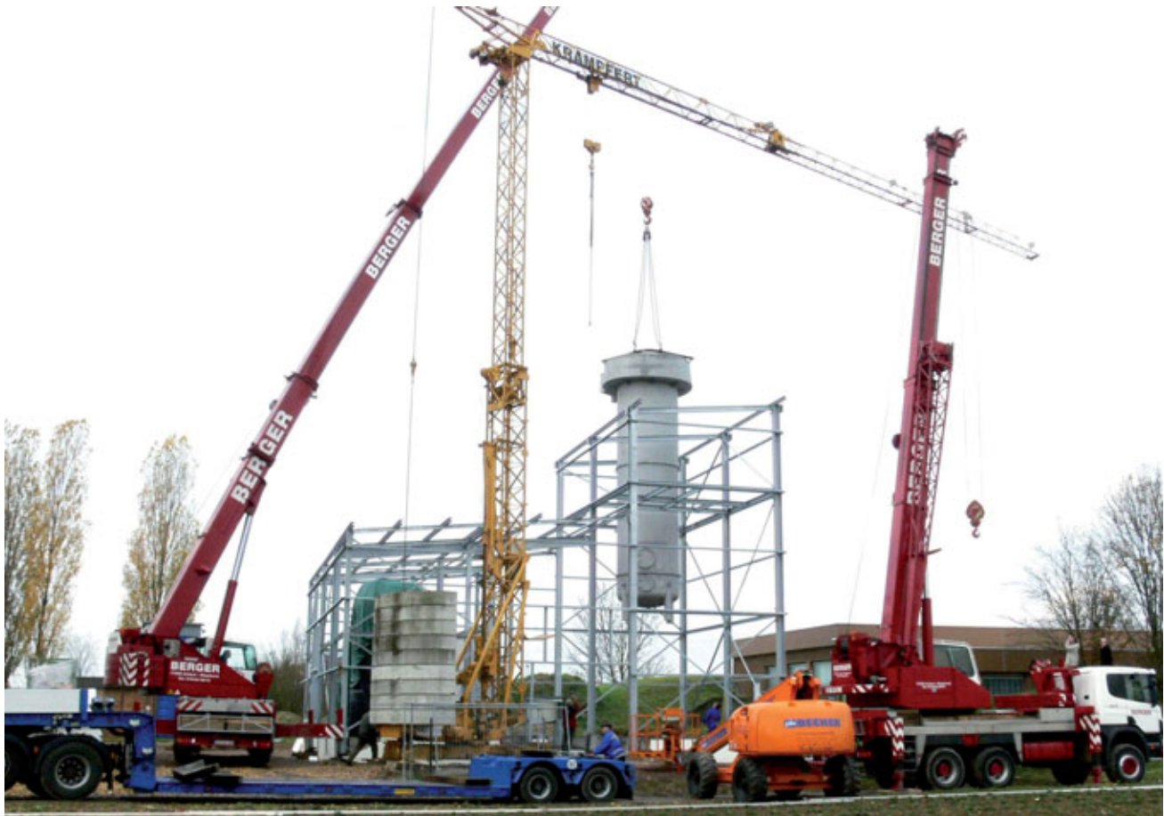
Abb. 2 Montage des Reaktors und der Stahlhalle
