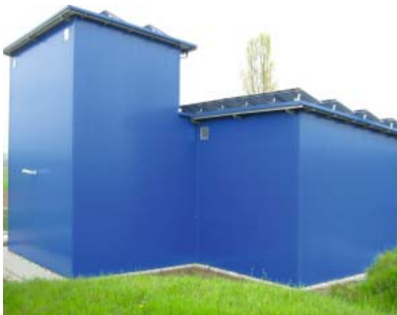
Bild 1. Das Wasserwerk Rotherst der Stadt Achern. © Hydro-Elektrik GmbH
