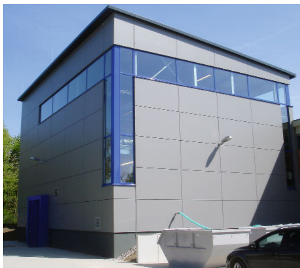
Bild 1. Trinkwasserenthärtungsanlage im WW Ottersdorf. © IB Eppler
