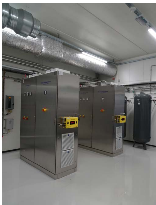
Bild 2: Ozonerzeugungsanlagen in Schrankausführung
