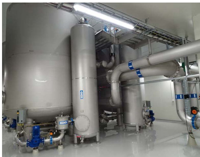
Bild 3: Filterbehälter mit Ozoninmisch- und Reaktionssystem
