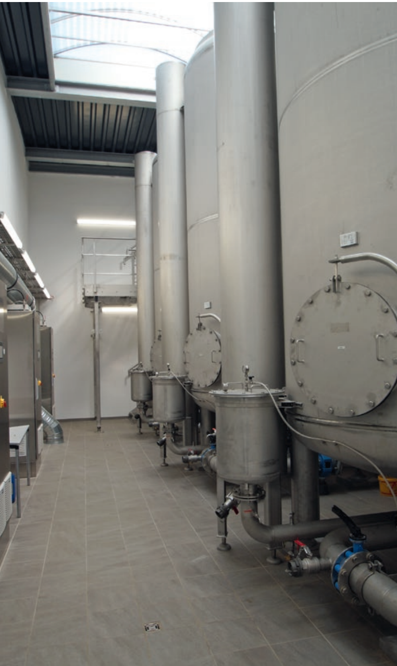
Abb. 7 – Ozonerzeuger links und Biofiltrationsanlagen rechts
