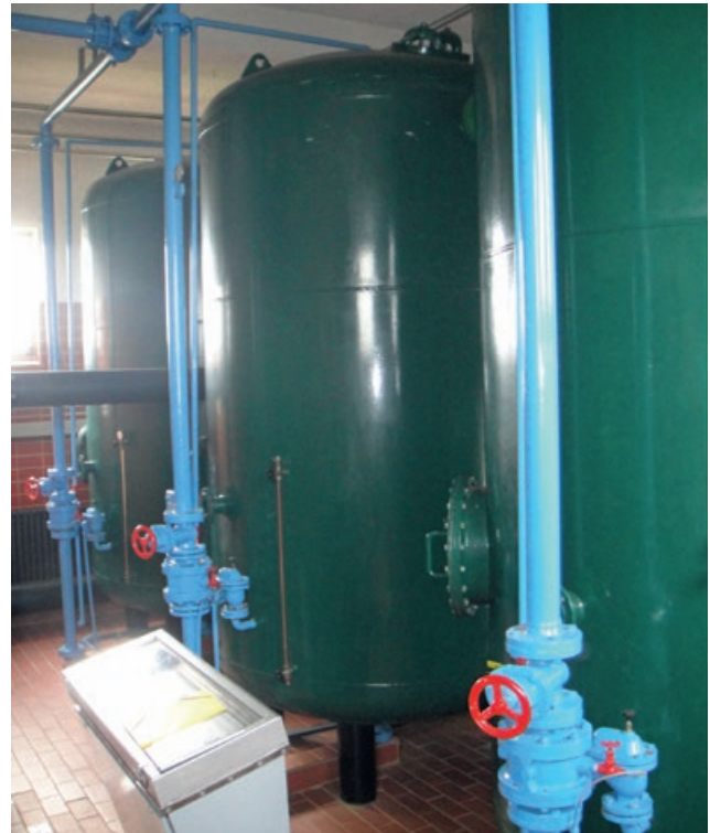
Abb. 3 – Bestehende Druckfilteranlage
