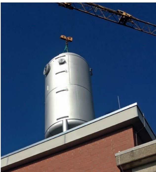
Abb. 6 – Einsetzen der Filterbehälter
